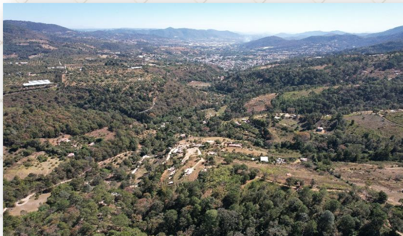
Zona de Riesgo por Deslizamiento de Ladera en la Comunidad de Ahuacatlán.
